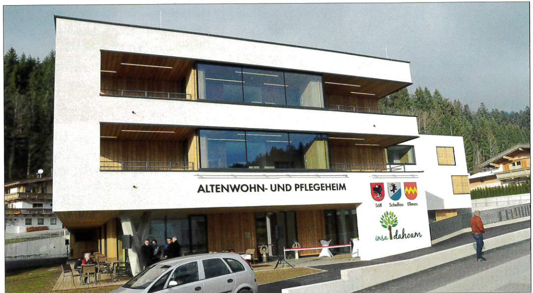
Das neue Altenwohn- und Pflegeheim in Scheffau entspricht den modernsten Anforderungen.
