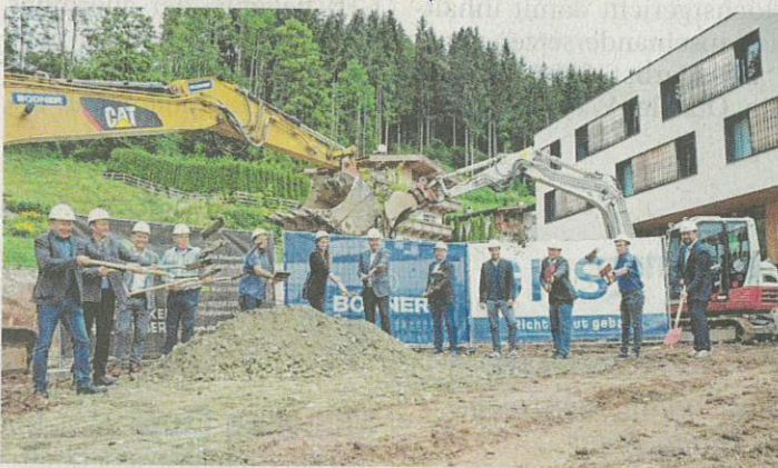
Vertreter aus Wirtschaft, Politik und Sozialbereich trafen sich zum Spatenstich, darunter BM Alois Horngacher (Söll, 2. v. l.), VBM Gerhard Schermer (Ellmau, 3. v. l.) und BM Christian Tschugg (Scheffau, 5. v. r.).
